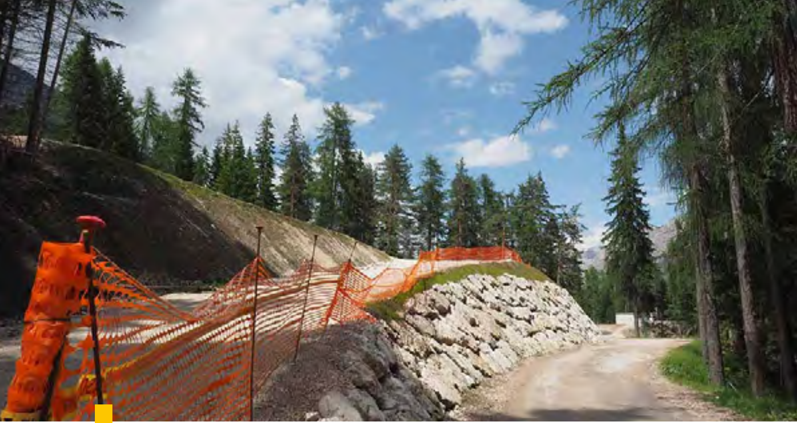
Muro di Contenimento, Gilardon, Cortina d'Ampezzo, Foto di Fabio Tullio
