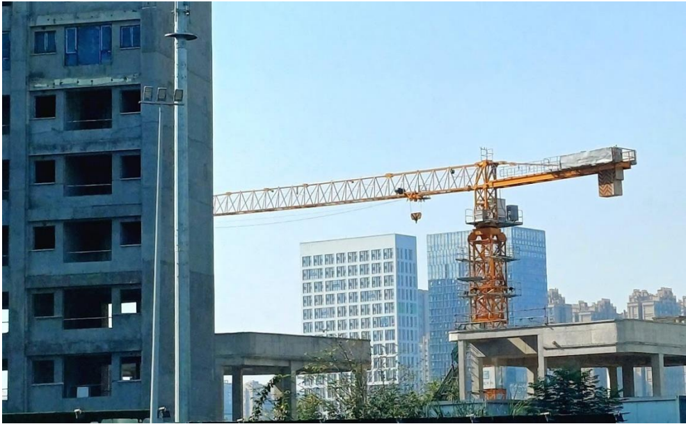
Figura 1. Edifici in costruzione
