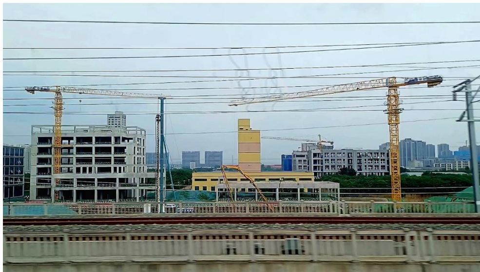
Figura 62. Edifici in costruzione
